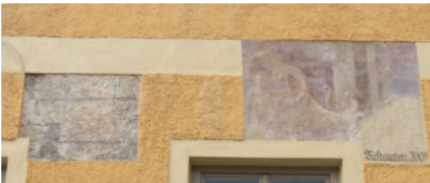
Unter der Haut: Was unter den Fassadenoberflächen von Imst historischen Häusern alles schlummern kann, zeigte sich im Rahmen der 2009 am Vereinshaus durchgeführten Außenrestaurierung Foto: Stefan Handle
